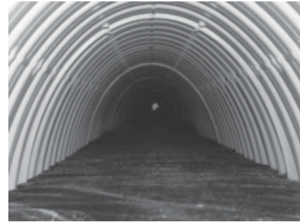
Figura 2. Descarga con maquinaria de 24 a 60 pulgadas.
